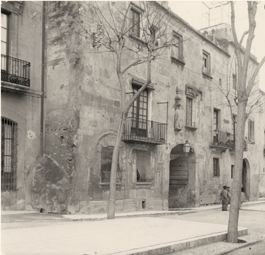
Façana de l'antic Hospital de Santa Tecla (Fotografia datada l'any 1915)
